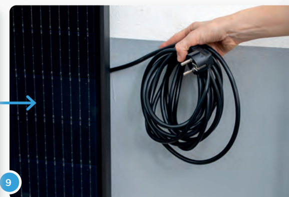
Achte darauf, dass du das Stromkabel vor dem Fixieren der Panele hinten herausführst, sodass es später griffbereit zum Einstecken liegt.
