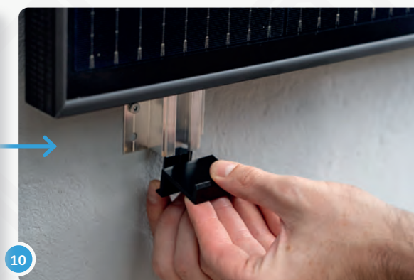
Bringe nun das Panel in die gewünschte Position und lass dir beim Anbringen der Klemmen von jemandem helfen.
