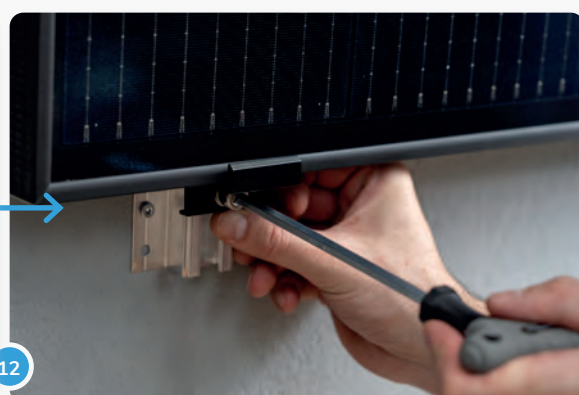
Wenn sich die Klemme in der endgültigen Position befindet, kannst du sie mithilfe der Schrauben und eines Drehmomentschlüssels fixieren. (Das richtige Drehmoment wird vom Hersteller angegeben.)
