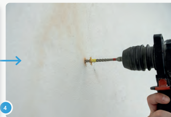
Bohre nun mit einem passenden Bohrer an den vorgesehenen Stellen Löcher...
