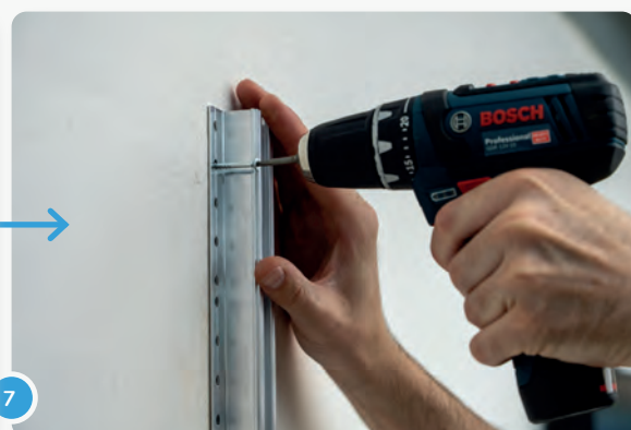
Jetzt kannst du die Schienen mit mind. vier Schrauben (nicht im Lieferumfang enthalten) pro Schiene montieren. Zwei Schrauben oben...
