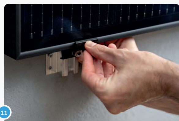
Die Klemmen werden von oben bzw. vorne in die Schienen gedrückt. Beim Hinunterdrücken dreht sich die Feder um 90° und schnappt ein.
