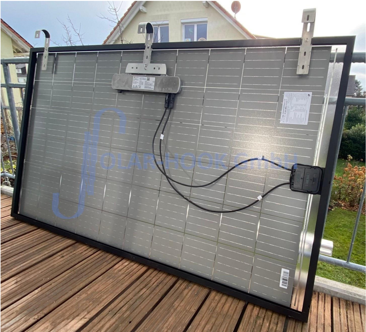
Abb. 7/vorbereitetes Solarmodul mit 3 Befestigungsbügeln und Wechselrichter
