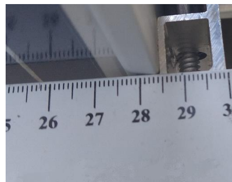
Abb. 13/Endklemme sicher anbringen
