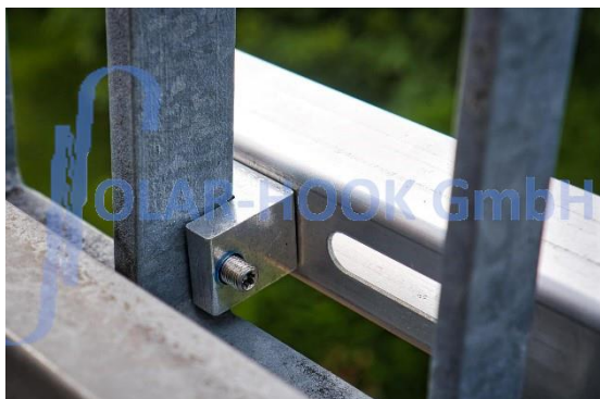
Abb. 8b/Spezialklemme an eckigem Geländerstab
